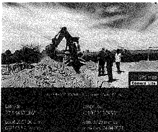
Excavación de red de alcantarillado de 8" y construcción de registros sanitarios en la Localidad de Santa Teresa
